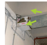
Cementno vezana izolacija sestavnih delov in inštalacij
