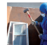
Odstranjevanje okenskih stekel s kladivom (zunaj)
